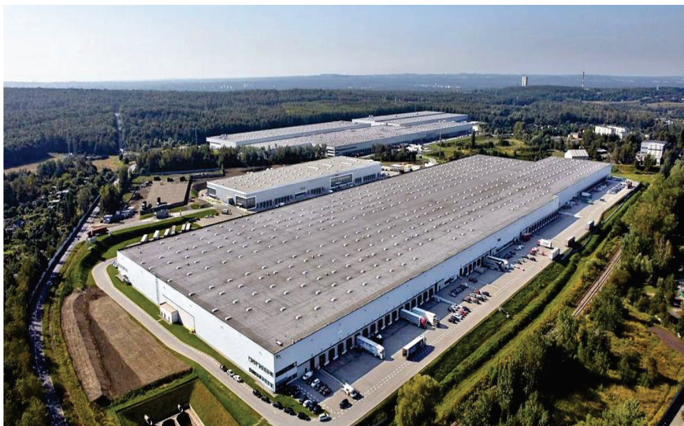
Rys. 8. Prologis Park Chorzów to centrum logistyczne, które na terenie pięciu hal oferuje ponad 250 000 m 2 powierzchni magazynowo biurowej
